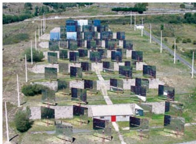
Figure 11 : la batterie d'héliostats disposés en terrasse en face du four solaire (photo Serge Chauvin).
